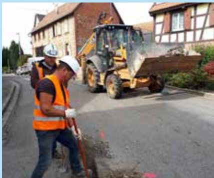
Travaux pour la pose du Très Haut Débit dans la rue principale à Dauendorf
