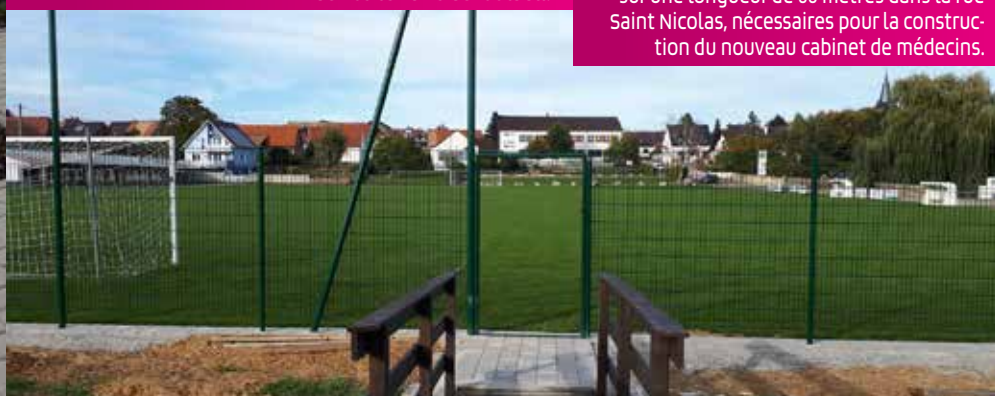
Montage de grillages et de filets de protection et divers aménagements autour du terrain de football. Travaux réalisés bénévolement par les membres du FC Dauendorf et matériaux pris intégralement en charge par la commune.
