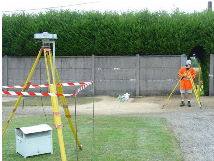
Entretien du réseau de nivellement
