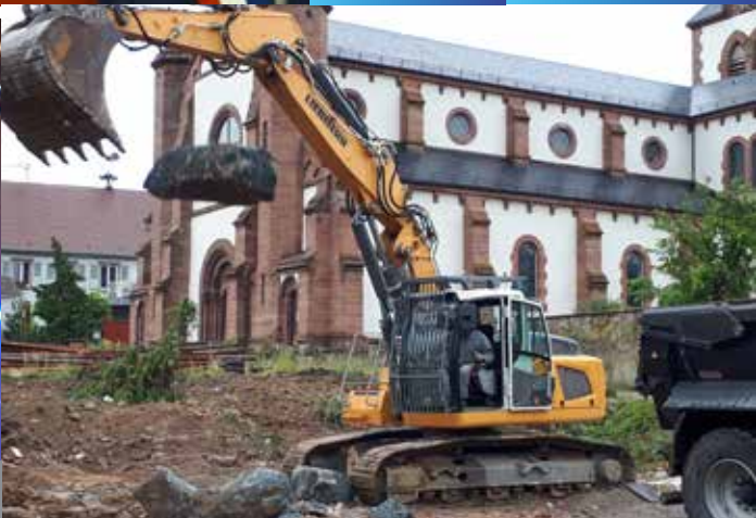
Photo impressionnante prise lors des travaux du centre village en juin
