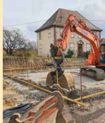
5 mars : les travaux de gros œuvre débutent
