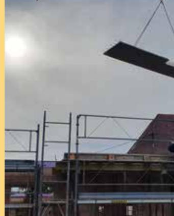
4 mai pose de la dalle
