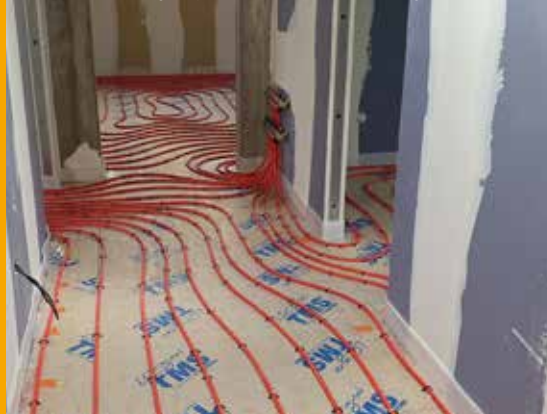
20 août : et des tuyaux partout au sol pour le chauffage
