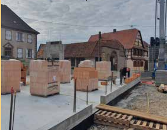
8 avril : début des travaux de maçonnerie
