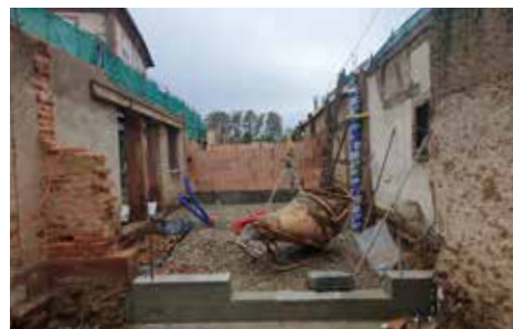
16 novembre 2023 - les travaux gros œuvre progressent
