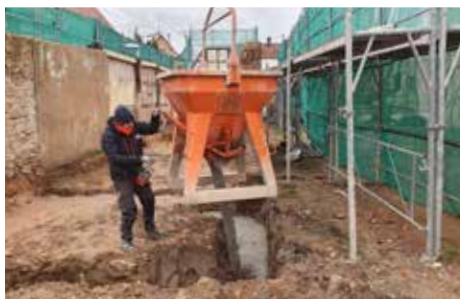
14 novembre 2023 - Antoine bétonne les fondations
